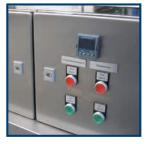
Control de temperatura del agua de proceso mediante controlador individual
